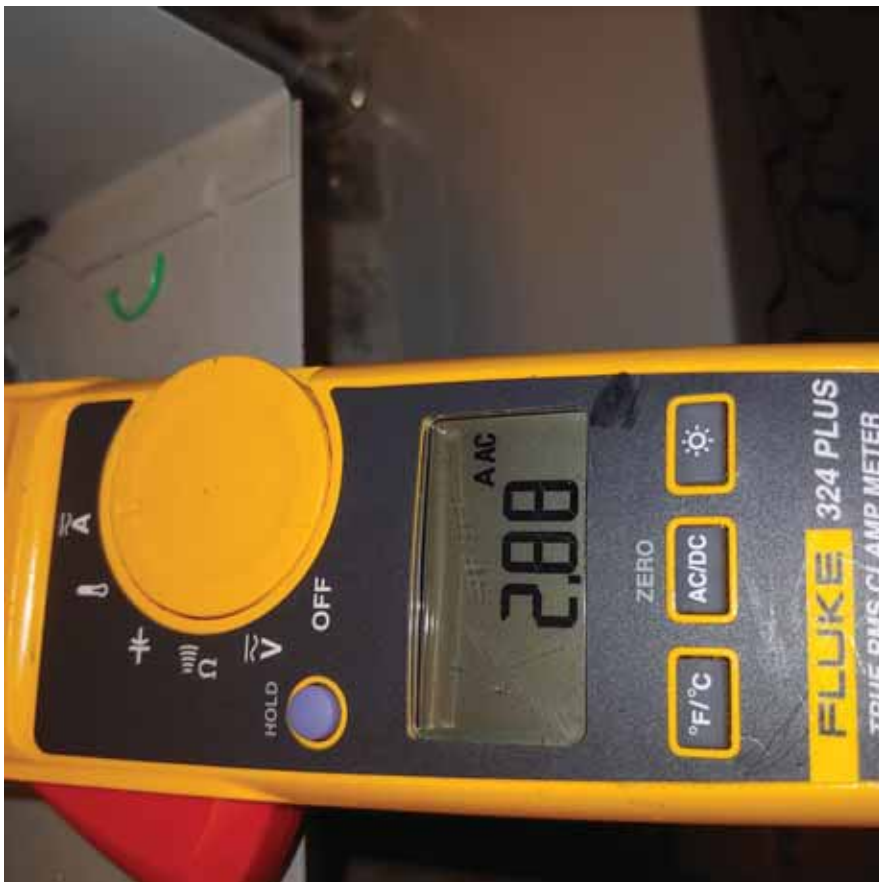
Server/PIC-ahu 2a blower amps.jpg
